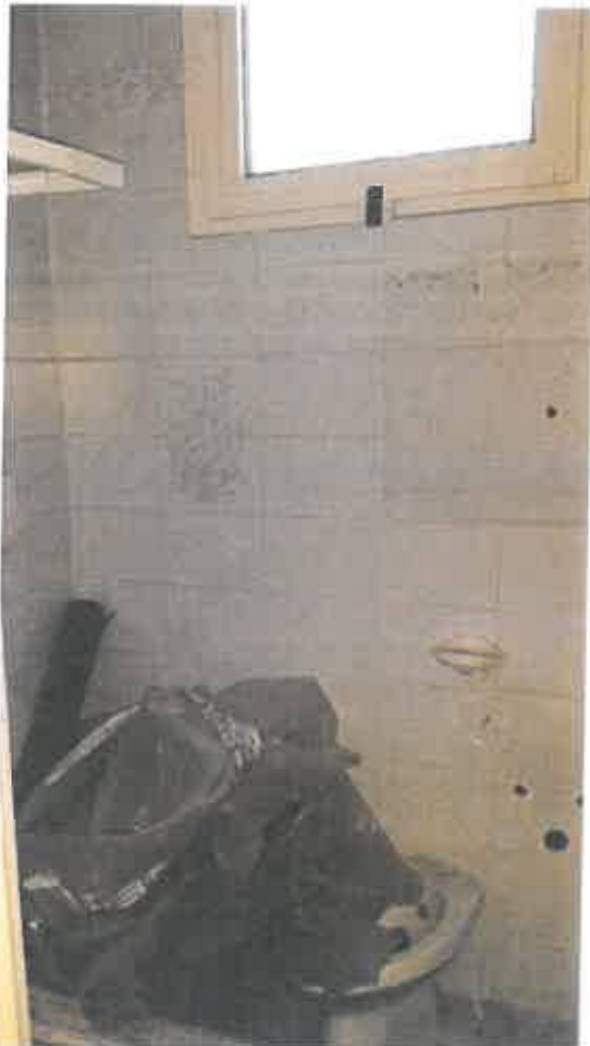
Foto – Locale servizio igienico piano terreno
