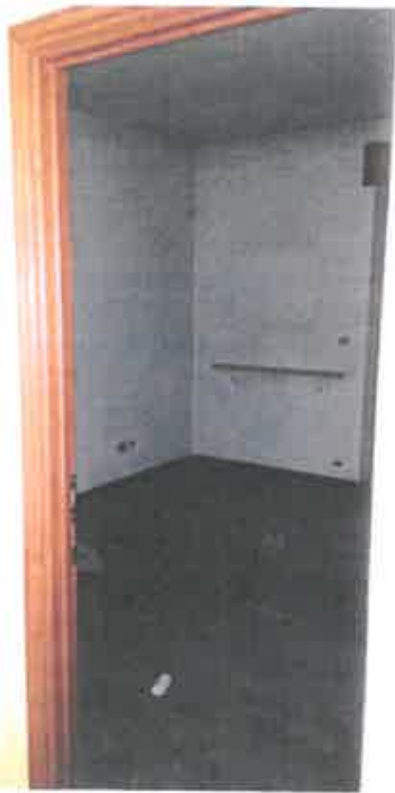
Foto – Locale piano primo
