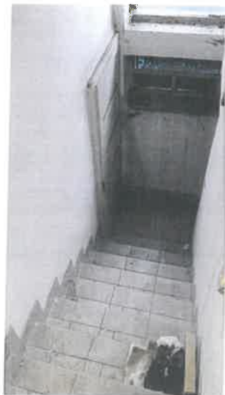
Foto – scala che collega P.T. e P. Int.
