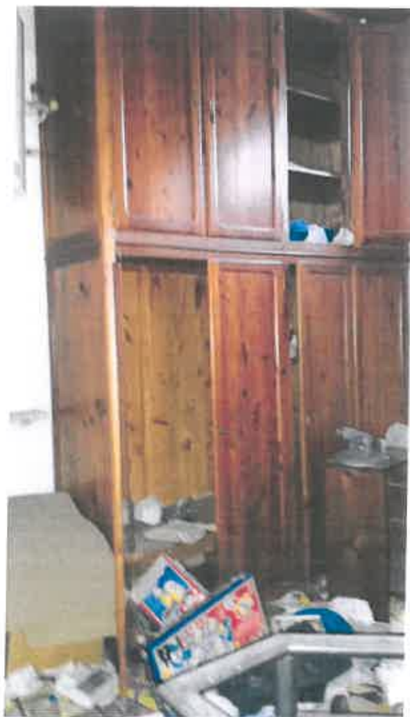
Foto – Locale sottotetto
