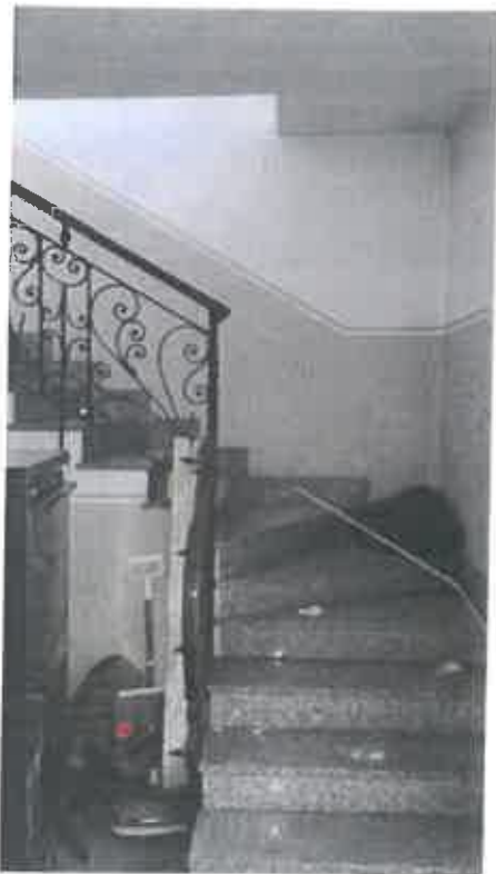
Foto – scala che collega P.T. e P. 1°
