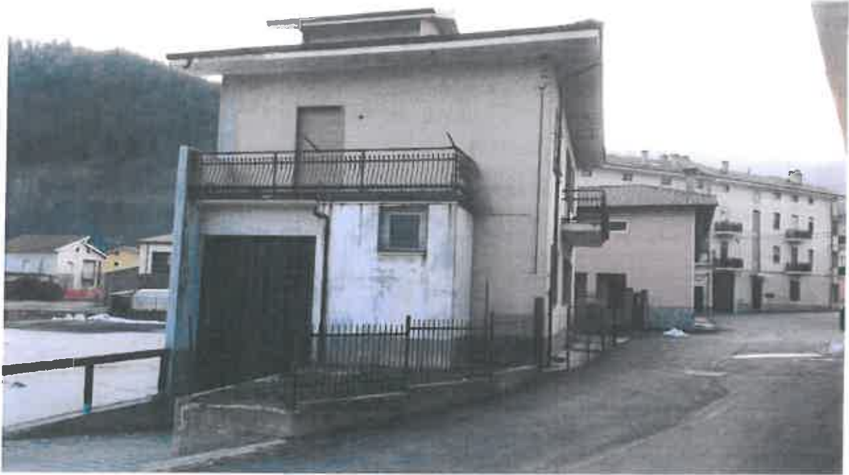
Foto – Prospetto Ovest
