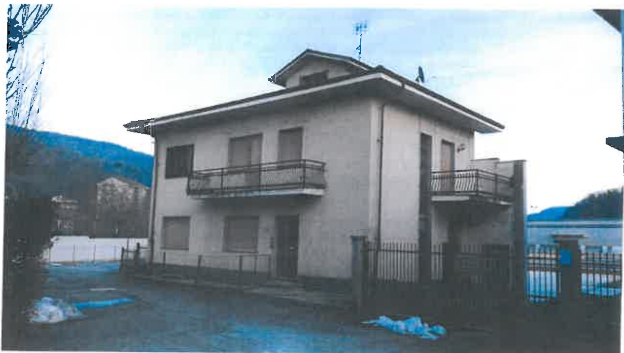
Foto – Prospetto Sud
