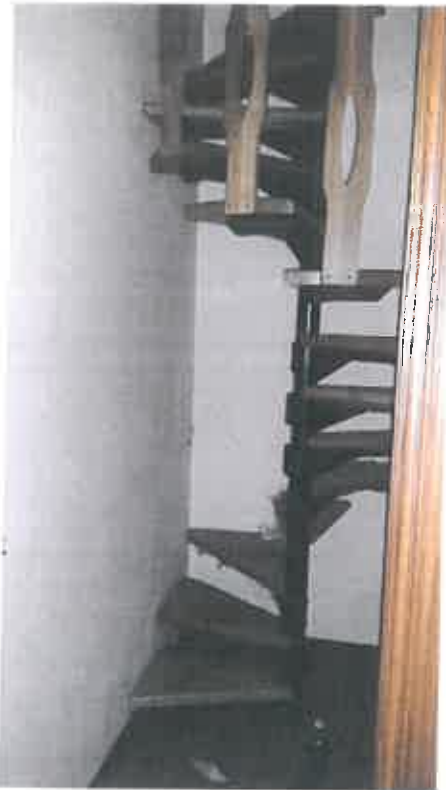
Foto – scala che collega P. 1° P. Sottotetto
