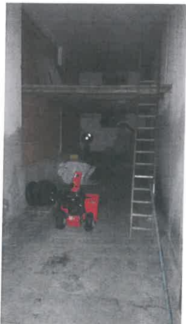
Foto – Locale interrato con accesso esterno
